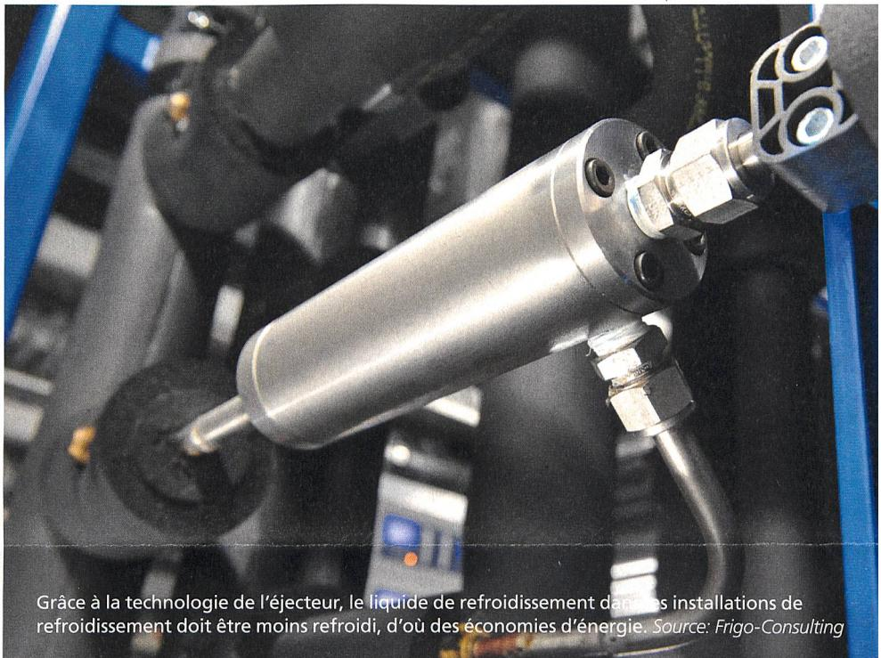
Grâce à la technologie de l'éjecteur, le liquide de refroidissement dans les installations de refroidissement doit être moins refroidi, d'où des économies d'énergie. Source: Frigo-Consulting
