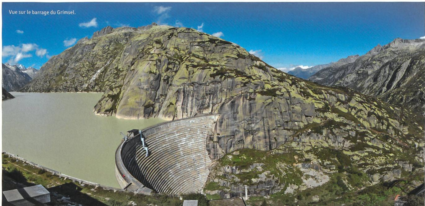
Pour produire de l'électricité, les quatre turbines de la centrale Grimsel 2 utilisent la hauteur de chute de 400 mètres entre l'Oberaarsee et le lac du Grimsel. Avec une puissance installée de 348 mégawatts, elles génèrent un bruit assourdissant, ce qui n'est pas étonnant, car jusqu'à 93 mètres cubes d'eau tonitruante déboulent chaque seconde sur les turbines. Grâce à un joint labyrinthique, les 50 bars de pression agissant sur les installations à pleine charge ne peuvent pas s'échapper.
