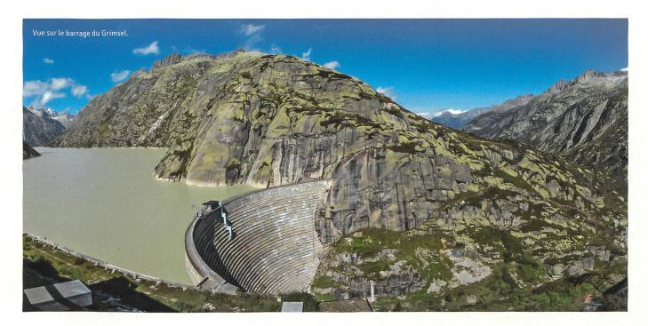
Pour produire de l'électricité, les quatre turbines de la centrale Grimsel 2 utilisent la hauteur de chute de 400 mètres entre l'Oberaarsee et le lac du Grimsel. Avec une puissance installée de 348 méga-watts, elles génèrent un bruit assourdissant, ce qui n'est pas étonnant, car jusqu'à 93 mètres cubes d'eau tonitruante déboulent chaque seconde sur les turbines. Grâce à un joint labyrinthe, les 50 bars de pression agissant sur les installations à pleine charge ne peuvent pas s'échapper.
