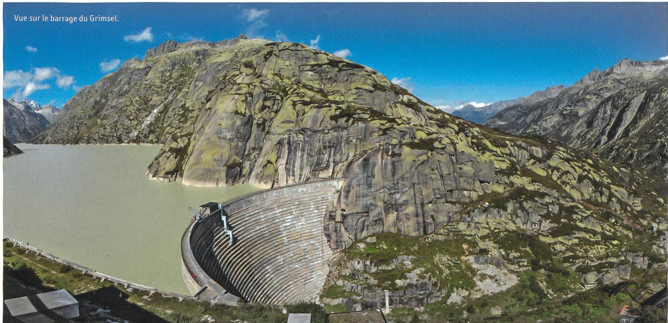
Pour produire de l'électricité, les quatre turbines de la centrale Grimsel 2 utilisent la hauteur de chute de 400 mètres entre l'Oberaarsee et le lac du Grimsel. Avec une puissance installée de 348 mégawatts, elles génèrent un bruit assourdissant, ce qui n'est pas étonnant, car jusqu'à 93 mètres cubes d'eau tonitruante déboulent chaque seconde sur les turbines. Grâce à un joint labyrinthique, les 50 bars de pression agissant sur les installations à pleine charge ne peuvent pas s'échapper.
