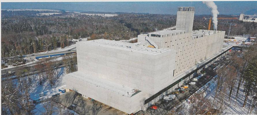
Vue de l'extérieur, la centrale énergétique ressemble à un énorme porte-conteneurs en béton. La proue est occupée par le bâtiment de service; au milieu, la structure massive surmontée d'une cheminée abrite l'incinérateur des déchets, la centrale thermique au bois et la centrale à cycle combiné; à l'arrière, la passerelle de commandement surplombe la fosse de stockage des déchets. Battant le pavillon d'Energie Wasser Bern, le cargo met le cap sur la sortie du nucléaire.
