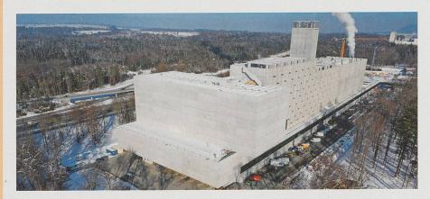
Vue de l'extérieur, la centrale énergétique ressemble à un énorme porte-conteneurs en béton. La proue est occupée par le bâtiment de service; au milieu, la structure massive surmontée d'une cheminée abrite l'incinérateur des déchets, la centrale thermique au bois et la centrale à cycle combiné; à l'arrière, la passerelle de commandement surplombe la fosse de stockage des déchets. Battant le pavillon d'Energie Wasser Bern, le cargo met le cap sur la sortie du nucléaire.
