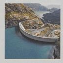
La centrale de pompage-turbinage de Nant de Drance permet d'effectuer du pompage-turbinage entre le lac d'Emosson et celui du Vieux Emosson, situé 295 mètres plus haut. La centrale de Nant de Drance sera équipée de six turbines de 150 MW chacune, soit une puissance totale de 900 MW. Le barrage de Vieux Emosson va être rehaussé de 20 mètres.
