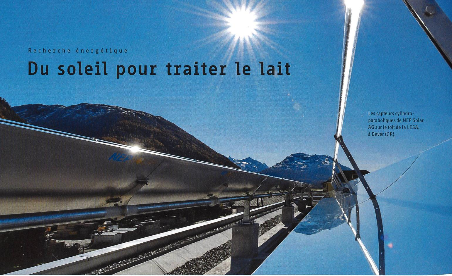
Les capteurs cylindro-paraboliques de NEP Solar AG sur le toit de la LESA, à Bever (GR).
