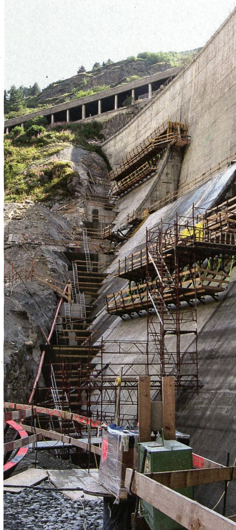
Travaux de confortement sur le barrage des Toules.
