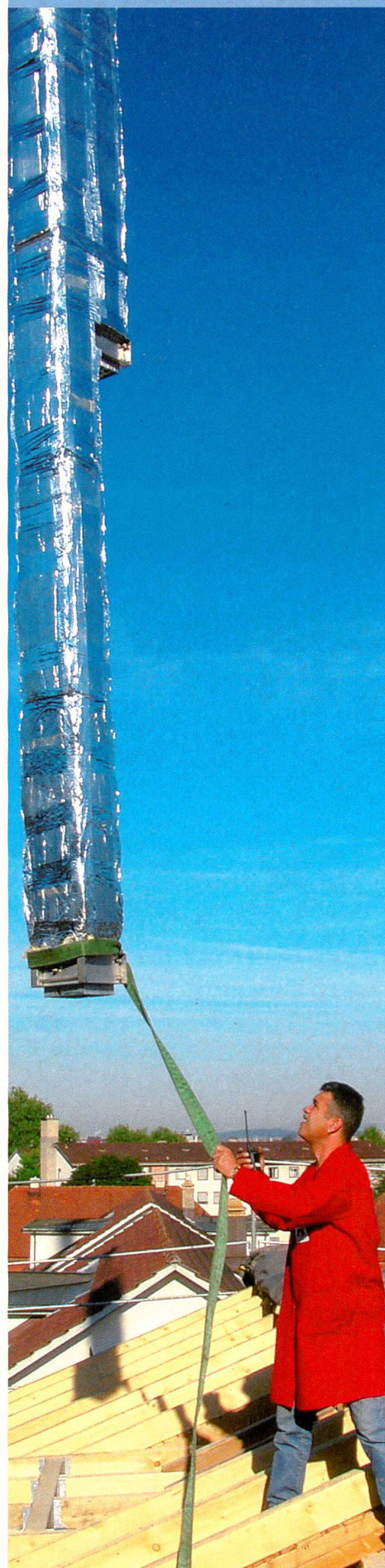
Installation d'un système central de ventilation.
