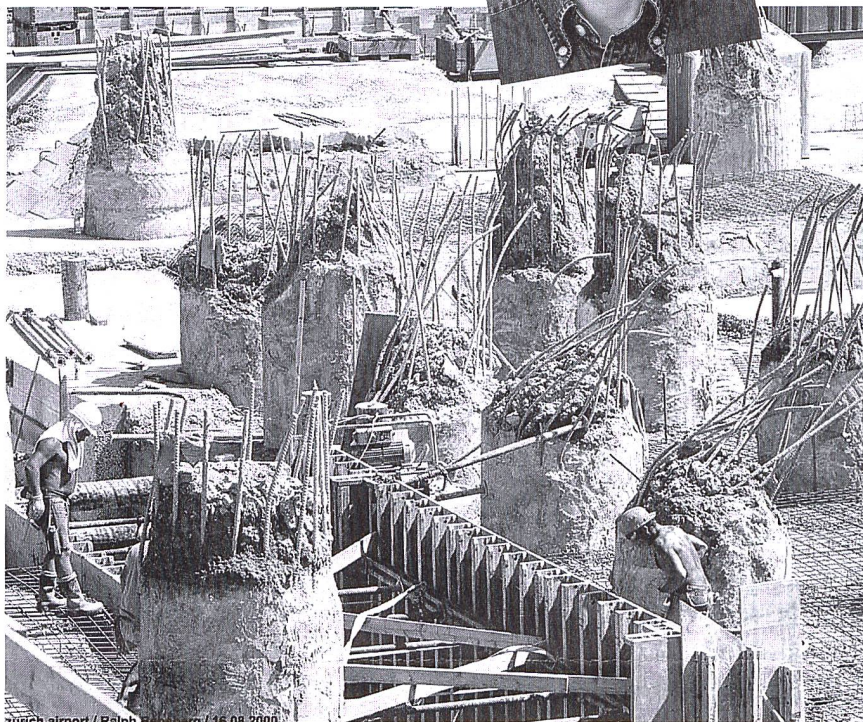
Les pieux énergétiques de l'aérogare zurichoise.
