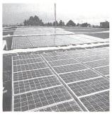
Depuis 1994, la Centrale photovoltaïque de 65 KW au Stade Olympique fournit du courant à un prix de revient d'un franc/KWh environ, avec 570 m² de panneaux solaires.
