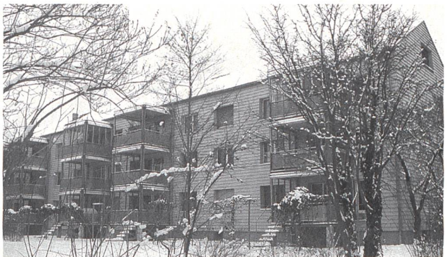
Exemple de rénovation judicieuse de bâtiments construits dans les années 60 (Soleure).
