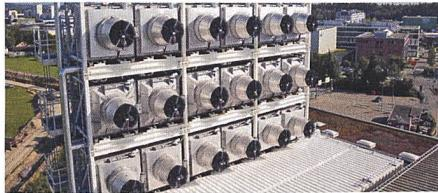
**04** Climeworks filtert CO<sub>2</sub> aus der Luft
