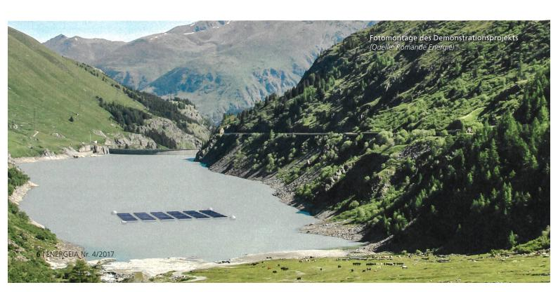
Mit dem Pilotprojekt kann ebenfalls getestet werden, ob der Bau eines solchen Parks finanziell tragfähig ist. Was die Wetterbedingungen im Winter anbelangt, so sollte Schneefall für die Module wegen der Rückstrahlung auf dem Schnee kein Problem sein (Albedo-Effekt). Die Rückseite der Module wird genügend Energie erzeugen, um den Schnee auf der Vorderseite zum Schmelzen zu bringen.
