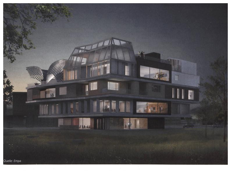
ver Gebäudetechnik: An der Glasfassade werden bewegliche Solarpaneele montiert, die sich nach dem Stand der Sonne ausrichten und das Raumklima regulieren werden. Insgesamt soll dieser Gebäudeteil rund 50 Prozent mehr Energie erzeugen, als er verbraucht.
