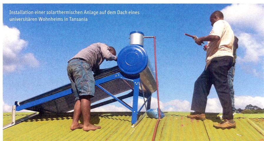
Installation einer solarthermischen Anlage auf dem Dach eines universitären Wohnheims in Tansania
