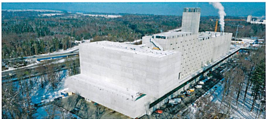
Von aussen sieht die Energiezentrale aus wie ein gewaltiges Containerschiff aus Beton: Zuerst die Kommandobrücke, die eigentlich der Kehrichtbunker ist. In der Mitte der mächtige Aufbau mit Kamin, der die Kehrichtverbrennung, das Holzheizkraftwerk sowie das Gas-und-Dampf-Kombikraftwerk beherbergt. Und schliesslich der Bug hinten im Bild, in dem das Servicegebäude untergebracht ist. Der Frachter fährt unter der Flagge von Energie Wasser Bern und ist auf Kurs Richtung Atomausstieg.
