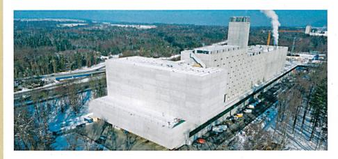
Von aussen sieht die Energiezentrale aus wie ein gewaltiges Containerschiff aus Beton: Zuerst die Kommandobrücke, die eigentlich der Kehrichtbunker ist. In der Mitte der mächtige Aufbau mit Kamin, der die Kehrichtverbrennung, das Holzheizkraftwerk sowie das Gas-und-Dampf-Kombikraftwerk beherbergt. Und schliesslich der Bug hinten im Bild, in dem das Servicegebäude untergebracht ist. Der Frachter fährt unter der Flagge von Energie Wasser Bern und ist auf Kurs Richtung Atomausstieg.
