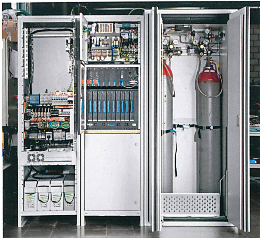
Integration eines kommerziellen Brennstoffzellensystems in ein System zur unterbrechungsfreien Stromversorgung.
