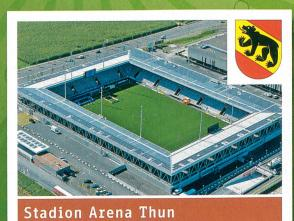
Stadion Arena ThunIn Betrieb seit:2011Panelfläche:2784 m²Leistung:402 kWJahresproduktion:355 000 kWh
