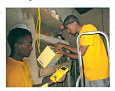
Installation eines Off-Grid-Solarsystems
