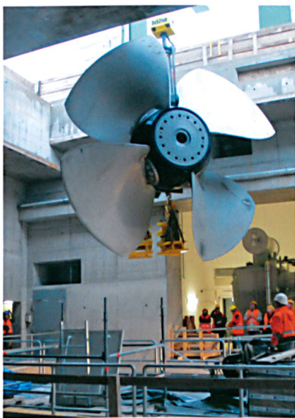
Das Einheben des Laufwerks für die Turbine erforderte millimetergenaues Arbeiten: Es wiegt 60 Tonnen und wurde in einem Stück angeliefert.
