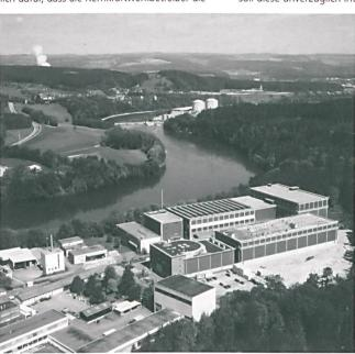
Im Zwischenlager in Würenlingen werden hochaktive, mittelaktive und schwachaktive Abfälle in getrennnten Hallen gelagert. Im Hintergrund die beiden Reaktoren Beznau I + II.
