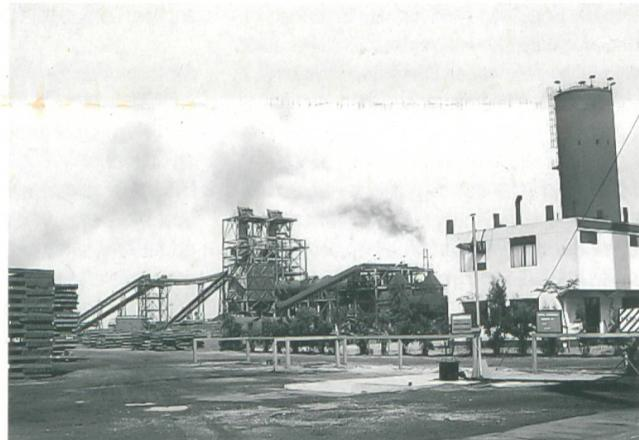
Kernstück der Studie des *Cleaner Production Centers* in Peru ist die Rückgewinnung von Wärme. Über Wärmetauscher wird Wasserdampf produziert, der in einer Dampfturbine zu Strom umgewandelt wird. Folgende Umwelteffekte wurden ausgemacht:
