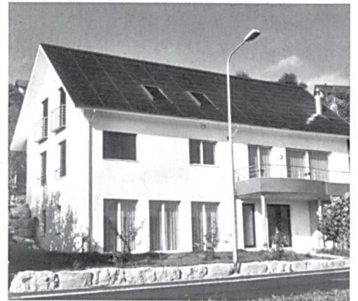
Einfamilienhaus Familie Erni, Untersiggenthal, mit dachintegrierter Fotovoltaikanlage
