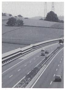
Projekt «Alpha A1» an der Autobahn A1 in Safenwil. Die 80kWp Fotovoltaikanlage speist seit Ende November 2000 sauberen Strom ins öffentliche Netz ein.
