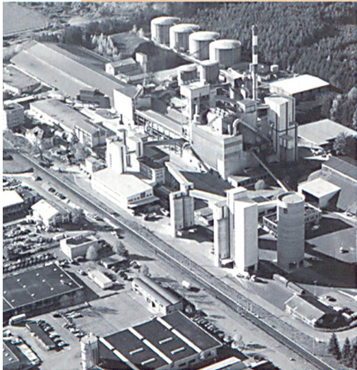
Das Werk Siggenthal der Holcim (Schweiz) AG produziert jährlich rund 750 000 Tonnen Zement.
