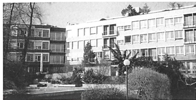
Bezirksspital Dielsdorf: Verschiedene Optimierungsmassnahmen sparen 20% des Gesamtenergieverbrauchs
