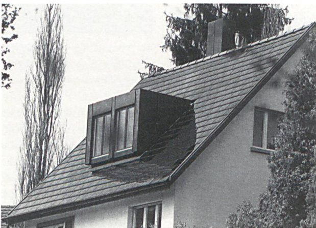
Dacherneuerung mit integrierten Sunslates (BS)
