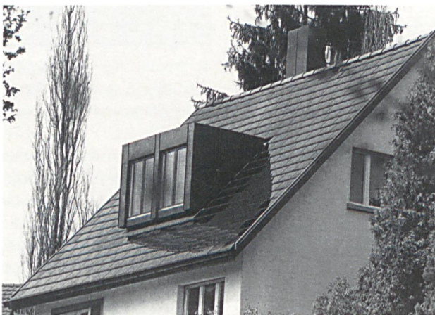
Dacherneuerung mit integrierten Sunslates (BS)
