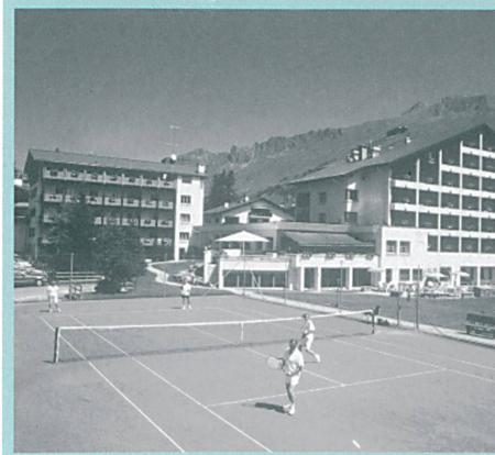
ZUM BEISPIEL: HOTEL VALBELLA INN, VALBELLA LENZERHEIDE Für weniger Heizkosten und Lüftungsaufwand: Viel Komfort für Gäste und Hauspersonal
