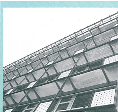
ZUM BEISPIEL: MIGROS GEWERBEHAUS, ZÜRICH Innen bringt die Aussensanierung echte Vorteile: Behagliche Arbeitsplätze dank gut isolierter Hülle
