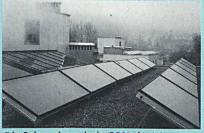
Die Solaranlage deckt 30% des Wärmebedarfs für Wasser.
