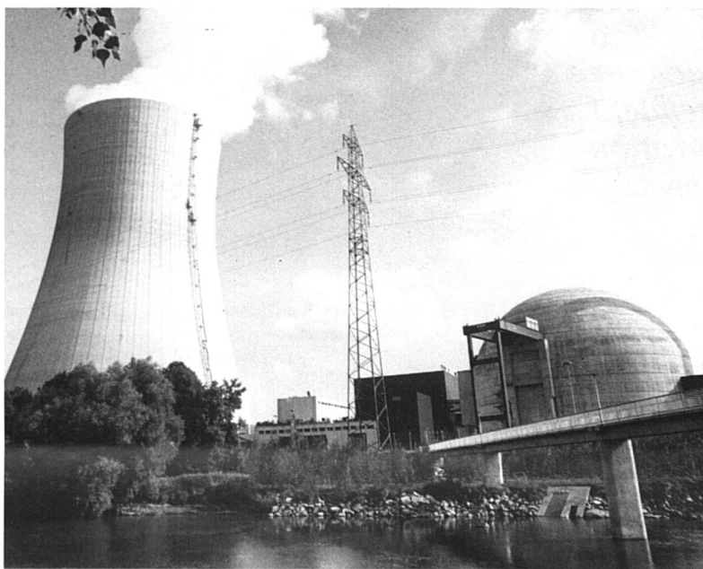
La centrale de Gösgen.
