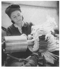
Bobineuse dans une fabrique de moteurs électriques en 1940 — Photo tirée de «Les Immobilisées».
