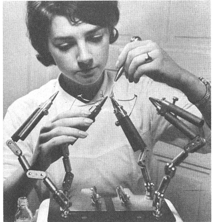
Soudage d'une monture
