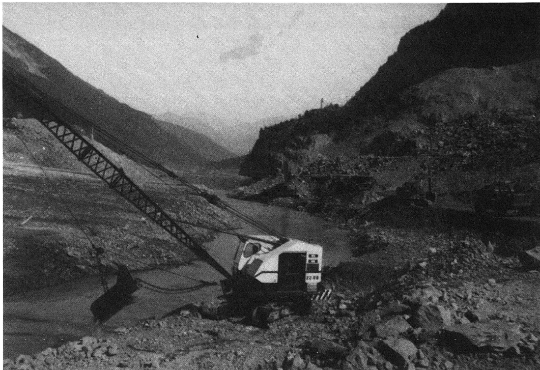
Fig. 12. Baggerung einer provisorischen Überlauftrinne. Blick talaufwärts. Aufnahme: 16.9.87.
