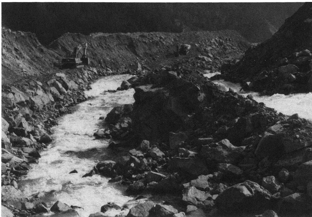
Fig. 13. Das Überlaufgerinne hat ein Gefälle von ca. 10%. Zur Sicherheit wird die natürliche Abpflasterung künstlich mit groben Blöcken verstärkt. Aufnahme: 16.9.87.
