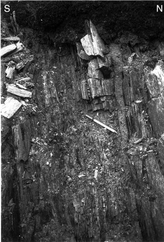
Fig. 7. Detailsicht der Störzone Nr. 20 (nach Frei 1999, westlich des geodätischen Messpunktes M2) In den gebänderten, mylonitisch verschieferten Störungsgesteinen tritt in der rechten Bildhälfte ein 3-5 cm breites Band von "Gesteinsmehl" auf (rechts der Bleistiftspitze). Links des Bandes ist eine starke, z.T. feinstückige Zerklüftung des ursprünglich duktil zerscherten Störzonenmaterials erkennbar.
