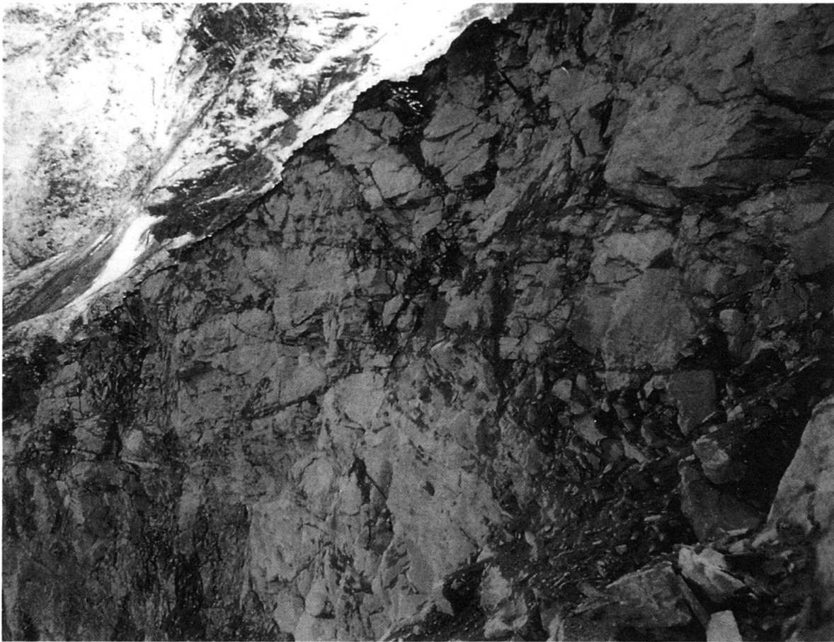
Fig. 12. Oberster Teil der Abrissnische vom 9. Mai 1991, oberhalb Kote 2200 m, Blick gegen das Bistal. Intensive Zerspaltung und Zerrüttung des Altkristallins. Das dunkel erscheinende Füllmaterial wird als Einschwemmung durch Grundwasser gedeutet, ist nichtbindig und besteht vermutlich hauptsächlich aus Sand und Silt. Staubablagerungen können ausgeschlossen werden, da die Staubwolken nicht bis hierher aufstiegen und deren Sedimente zudem viel heller wären. Foto A. Truffer am 10. Mai 1991.
