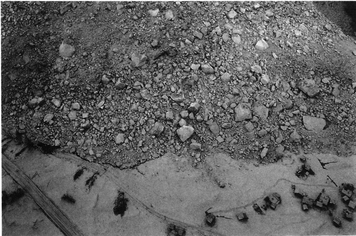
Fig. 6. Unterster Teil des Ablagerungskegels, Sturz vom 18. April 1991, Flugaufnahme der Schweizer Armee am 19. April 1991. Der Weiler Unter Lärch rechts unten blieb noch verschont, auch die Strasse (links untere Ecke) ist noch benutzbar, während die Eisenbahnlinie von den Trümmern nahe dem linken Bildrand erreicht wurde. Die in ihrer Nähe stehenden Bäume wurden durch den Luftstoss umgelegt, die Dächer der Häuser dagegen blieben grösstenteils an Ort. Mit Ausnahme eines Spritzers im mittleren Teil des Bildes ist der Sturzkegel scharf abgegrenzt, einzelne Blöcke erreichen eine gewaltige Kubatur. Eine dicke, helle Staubschicht bedeckt das Gelände.
