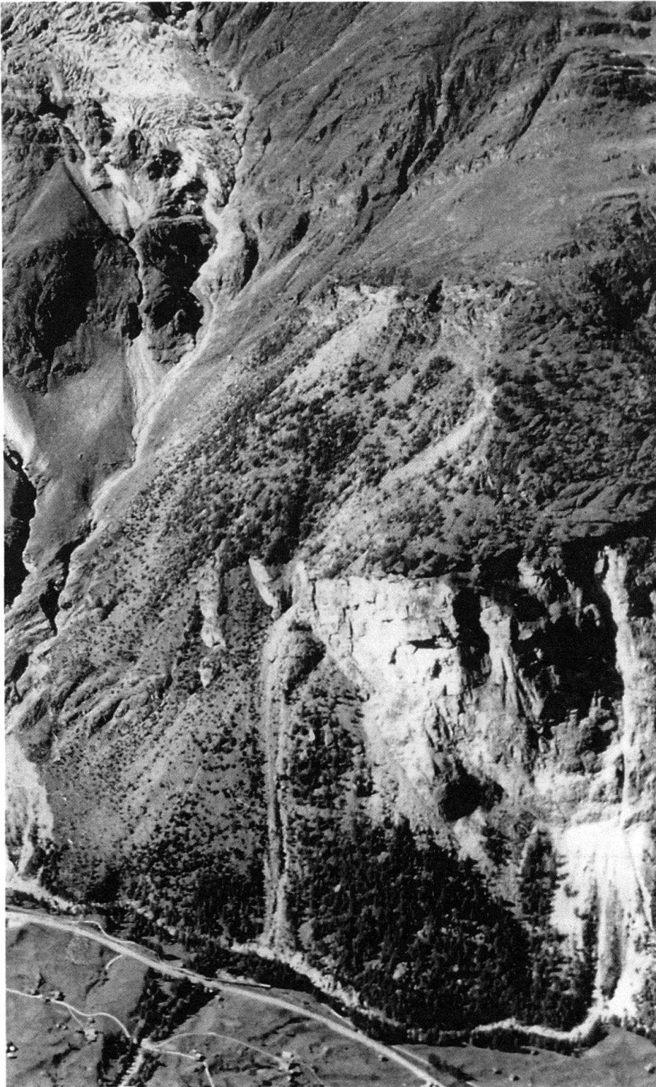
Fig. 4. Zustand des späteren Sturzhanges im Jahre 1972. Im Talgrund der Weiler Lärch, links das Bistal mit der Zunge des Bisgletschers. Die Abrissnische wird nach dem 9. Mai 1991 die rechte Hälfte des Bildes bis nahe zu den dunklen, horizontalen Felssimsen in der oberen Ecke erfassen, Punkt 117 bleibt unberührt (vergl. Fig. 9). Dieser Punkt liegt auf einer schräg nach links unten ziehenden alten Sackung. Die helle Felswand rechts besteht ausschliesslich aus Randagneis, darunter folgt im „Grossgufer“ Hochwald, dies mit Ausnahme eines Steinschlaggebiets am rechten Bildrand (mittlerer, stark zerklüfteter Teil der Wand). Foto H. Röthlisberger.
