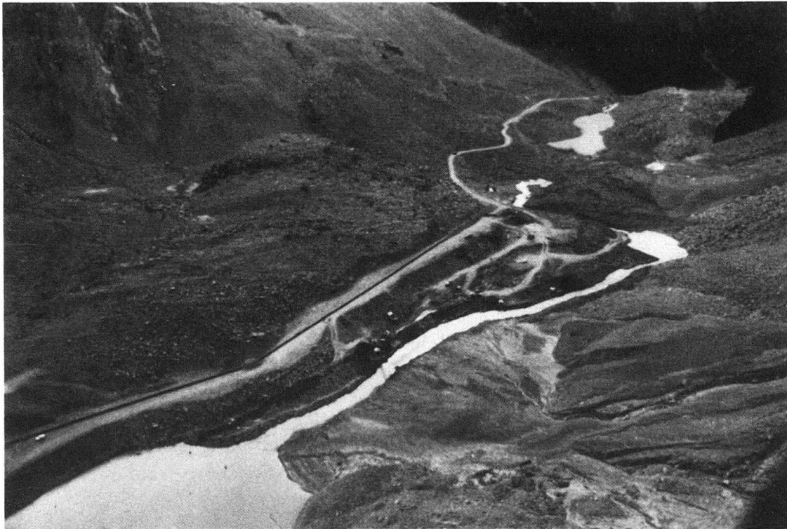
Fig. 9. Blick talabwärts. Die Topographie der Krone der Sturzablagerung ist verhältnismässig flach. Ersichtlich ist die in Ausbaggerung begriffene Überlaufrinne und die noch nicht eingedeckte Pumpleitung 1. Aufnahme: 16.9.87.
