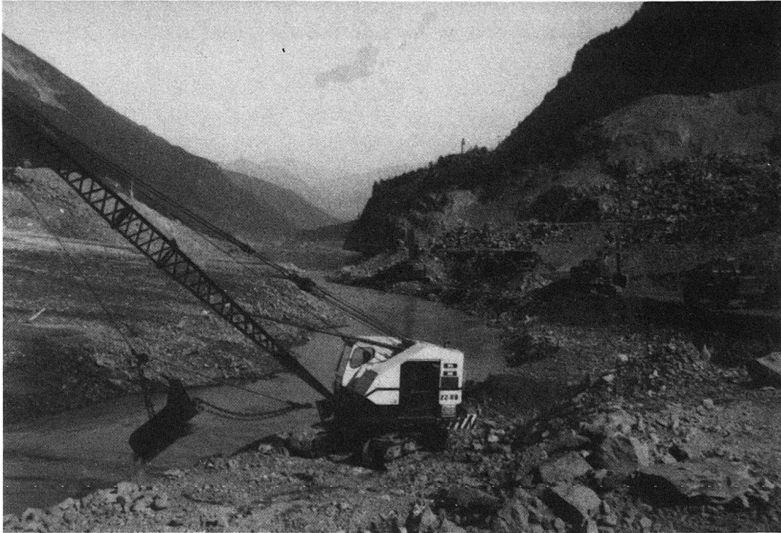
Fig. 12. Baggerung einer provisorischen Überlaufrinne. Blick talaufwärts. Aufnahme: 16.9.87.
