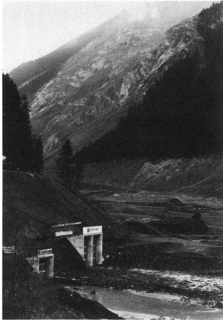
Fig. 16. Einlaufportale beider Umleitstollen. Im Hintergrund die Sturzbahn und der von der Schwallwelle abgetragene rechte Hangfuss. Der Talboden davor war früher der Grund des Bergsturzsees. Aufnahme: Juli 1990.
