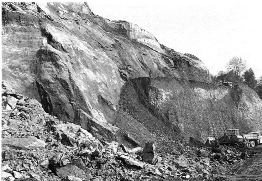
Fig. 11. Photo der Aufschlüsse in einer heute aufgefüllten Kiesgrube, (Lage siehe Figur 10). Photo 1: Blick nach Westen. Hinter dem Trax: Gleithorizont in Seebodenlehm, nahe oberem Rand des Bildes: Schieferkohle. Photo 2: Blick nach Nordosten. Gut sichtbare Gleitfläche und abgesunkene Scholle aus Kies, rechts. (Aufnahme: C. Schindler, Herbst 1971.)
