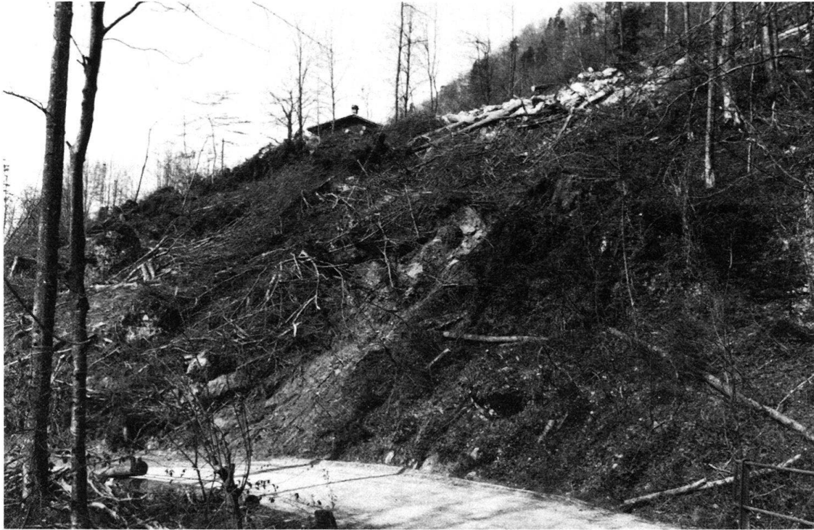
Fig. 3. Wegen lokaler Instabilitäten in den Böschungen mussten Bäume gefällt und schwach eingebundene Blöcke gesprengt werden. Am oberen Bildrand Dach des Hauses 1 (Aufnahme: 7. Mai 1979). (Bild: Neg. Nr. 9/50/15A; 7. Mai 1979.)
