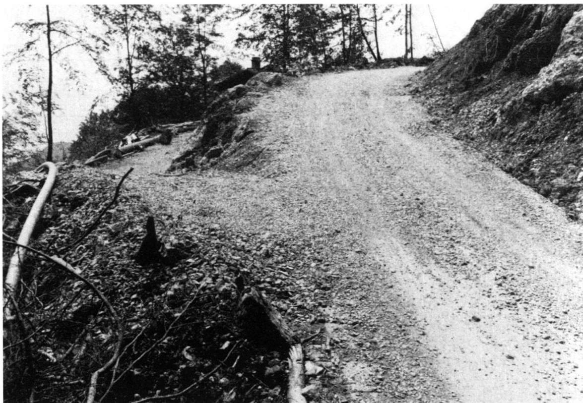
Fig. 11. Begradigung der Strasse beim Haus 1. Links alte, durch Rutschung verschobene Strasse (Aufnahme: 5. Juni 1979). (Bild: Neg. Nr. 9/48/13; 5. Juni 1979.)
