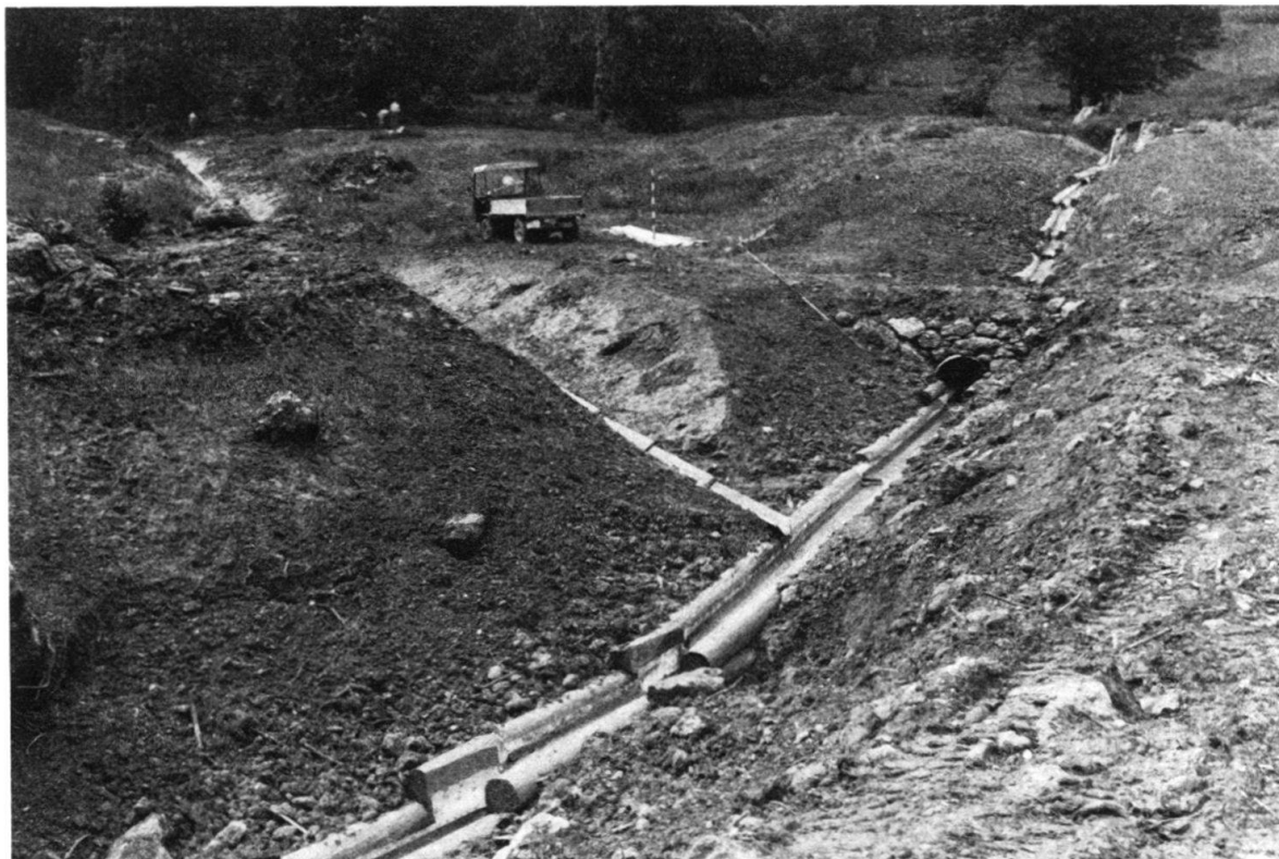
Fig. 10. V-Gräben oberhalb der obersten Rutschnarisse. Saalenbach in Holzkännel verlegt (Aufnahme: 5. Juni 1979). (Bild: Neg. Nr. 9/46/7; 5. Juni 1979.)
