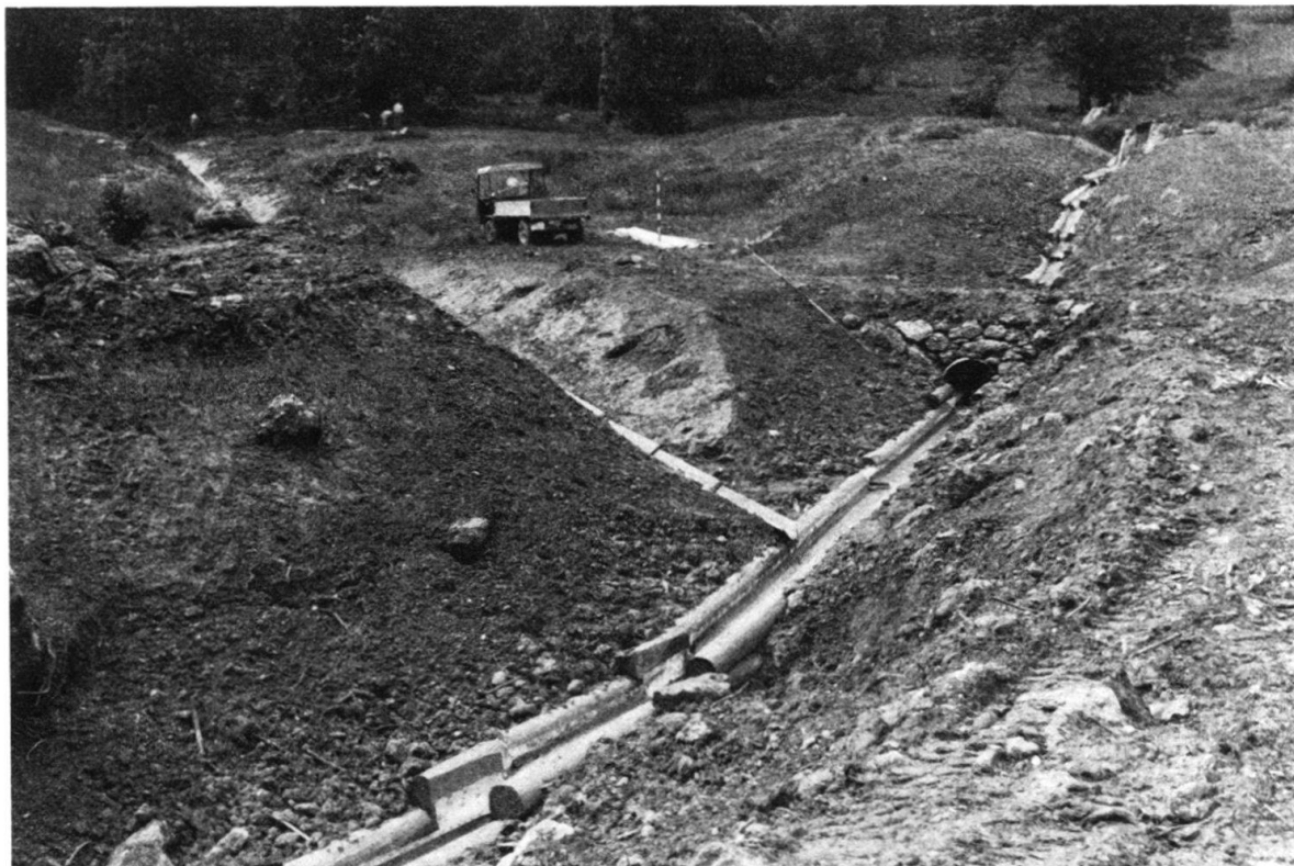
Fig. 10. V-Gräben oberhalb der obersten Rutschnarisse. Saalenbach in Holzkännel verlegt (Aufnahme: 5. Juni 1979). (Bild: Neg. Nr. 9/46/7; 5. Juni 1979.)
