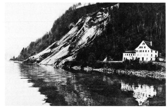
Fig. 4. Felsrutschung (Schlipfsturz) bei Mühletal am Walensee im Jahr 1924; gesamte Masse der beiden Rutschungen:  $200\,000-300\,000$  m³.
