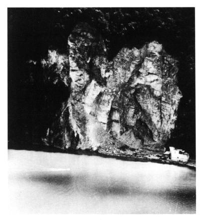
Fig. 3. (Fallsturz beim Steinbruch Obermatt am Vierwaldstättersee 1964, Masse des Sturzes 70 000 m³ (Die Weltwoche, Bildarchiv).
