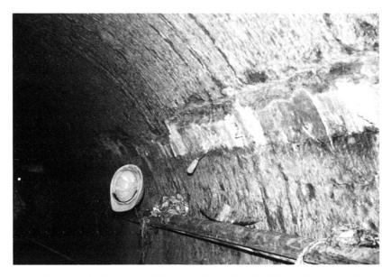
Fig. 4. Bentonit von Urdorf-Uetikon im Wasserstollen Hardhof-Strickhof, Stollenmeter 2150. Der Bentonit quillt stark hervor. Photo V. Longo.
