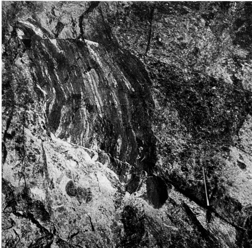
Fig. 10. Massiger Innertkirchner-Granit mit Biotitgneis-Scholle. An zwei Stellen wird die Scholle durch Überschiebungsflächen versetzt. Druckstollen Trift-Speicherberg, m 1729 ab Trift.
