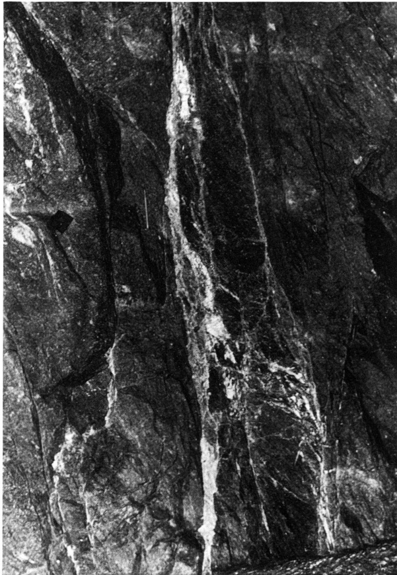
Fig. 15. Typisches Bild der Verästelung von Lettenmyloniten. Druckstollen Trift-Speicherberg, m 3470 ab Trift.
