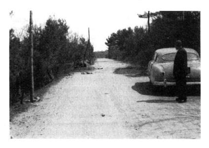
Fig. 10. Verschneidung der Hauptstrasse Balıkesir-Çanakkale im E von Yenice zwischen km 107 und 108 (etwa 200 m östlich km 108). Verschiebungsbetrag mindestens 2,5 m (spitzwinklige Verschneidung). Blick gegen E.
