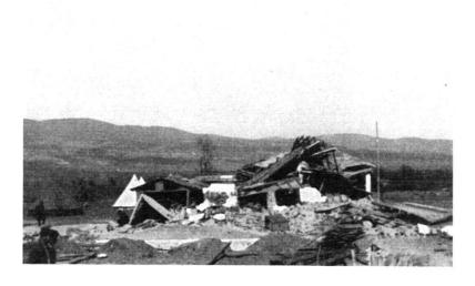
Fig. 6. Bild der Zerstörung in Yenice. Epizentralgebiet, zerstörender Stoss von unten.
