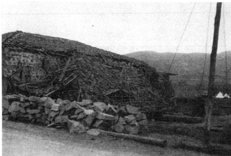
Fig. 8. Gemischte Konstruktion in Çan, seitwärts gestürzt.
