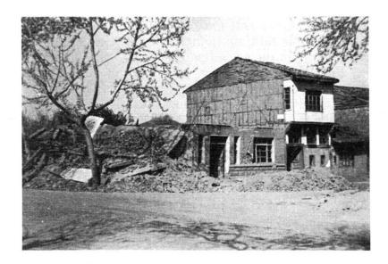
Fig. 4. Bild ungleicher Zerstörung in Gönen, links Backsteinhaus mit horizontalen Betonverstärkungen vollständig eingestürzt.
