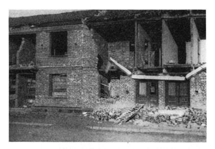
Fig. 7. Backsteinhäuser in Çan mit horizontalen Betonverstärkungen, Stoss von seitwärts zerstörend, senkrecht zur Stossrichtung orientierte Wände eingestürzt.
