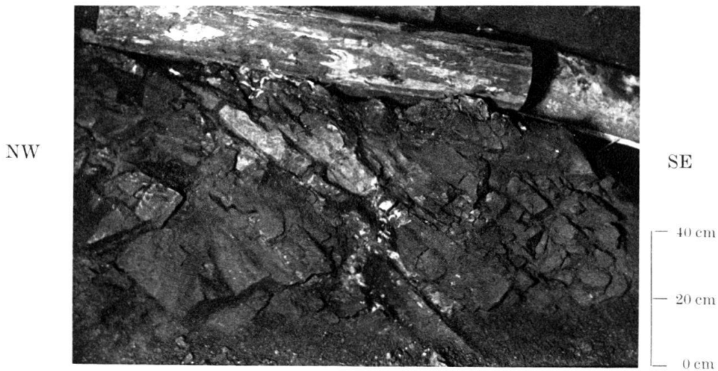
Fig. 2. Kohlenführende Verwerfung (Hauptverwerfung No. 9) zwischen Drusbergschichten (im Vordergrund) und Schrattenkalk. Aufnahme senkrecht zum Streichen der Verwerfung, welche mit 45^{\circ} bis 50^{\circ} nach NE einfällt und im obern Drittel des Bildes angeschnitten ist. Die beiden Einbauhölzer geben den Verlauf derselben, sowie der Kohle an, über welcher Schrattenkalk liegt (s. auch Fig. 3). — Aufn. in Grundstrecke 1803 bei Aufbruch 3. Phot. R. Schaer.
