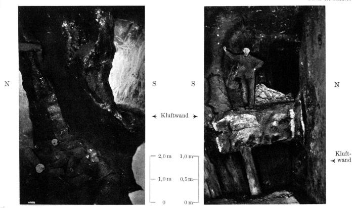
Fig. 10. Gleiche Kluft wie Fig. 9. Unterer Teil eines in Kohle eingelagerten Blockes von Schrattenkalk (ca. 800 Kubikmeter Inhalt). Siehe auch Taf. IV, Schnitt C. — Aufn. aus Abbaustrecke Kote 1763, ca. 10 m ostsüdöstlich Schacht Cornu.
