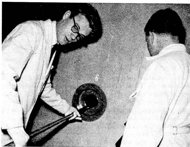
Un étudiant du Poly de Zurich travaille ici au réacteur Saphir, il procède au défournement d'un isotope d'un des canaux d'irradiation.
