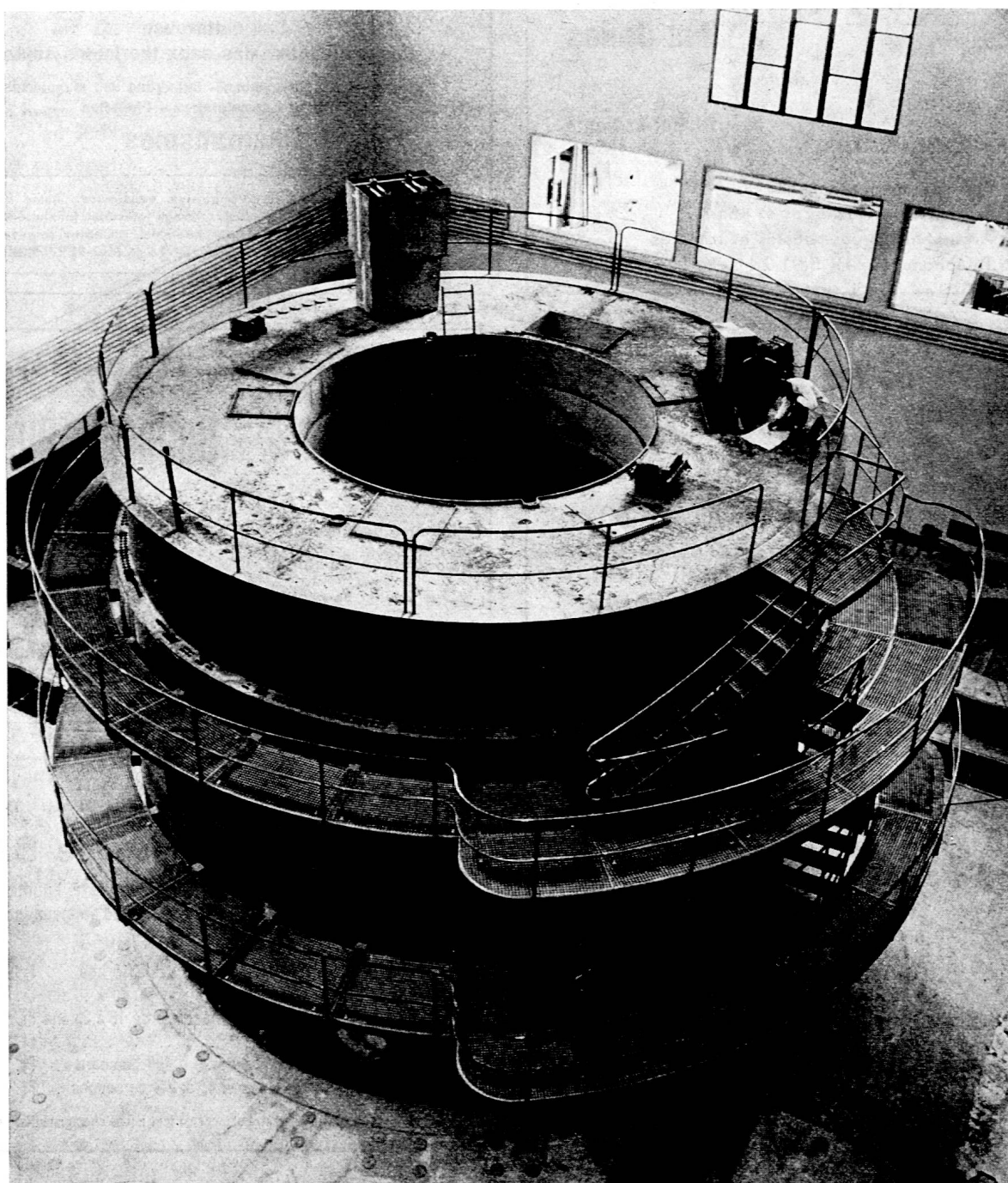
« SAPHIR » Swimming Pool, réacteur en fonction
