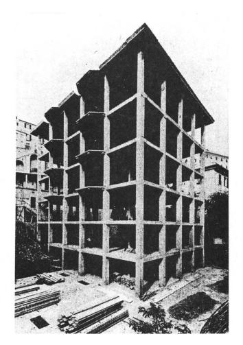
Fig. 14. — Maison d'habitation à Gênes, 1908. Piccardo et Caffarena, ingénieurs et architectes. Cette belle icône révèle la robustesse et l'incombustibilité initiales du système, avant son revêtement architectural. Les murs extérieurs de pierre seront larges de 45 cm.
