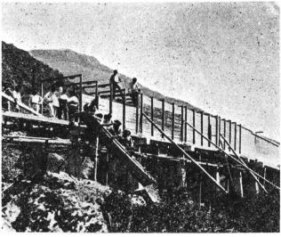
Fig. 8. — Canal hydraulique du Simplon près de Brigue. Vue des travaux au printemps 1898. Les fermes de métal permettent de récupérer les planches du coffrage. Monumentum deperditum.
