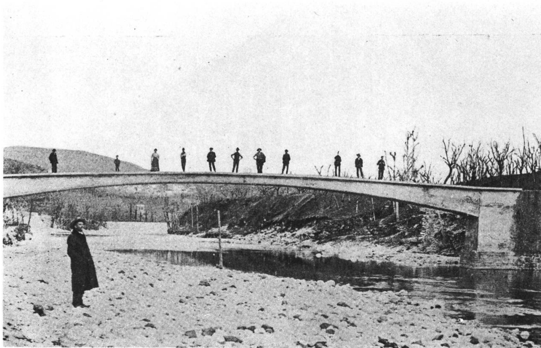
Fig. 19. — Pont routier sur l'Astico près de Calvene, en Italie, œuvre de l'ingénieur G. A. Porcheddu, agent turinois du brevet. Ouverture de 34 m 50. Photographie de l'inauguration, en 1908.
