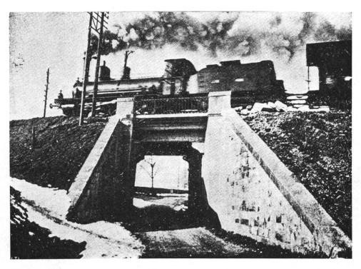
Fig. 9. — Pont ferroviaire au Creux du Mas près de Rolle, sur la ligne Lausanne-Genève, administrée par la C<sup>ie</sup> du Jura-Simplon. Dessinée en 1897 par l'ingénieur Samuel de Mollins, cette passerelle «monolithique» se construit en 1898. Pour montrer la fiabilité de son système, Hennebique publiera cette belle photographie toute une décennie. Incunable du béton armé, ce pont «travaille» encore en 1985. Seul l'élargissement de la route sous-jacente pourrait nous priver de ce monument.
