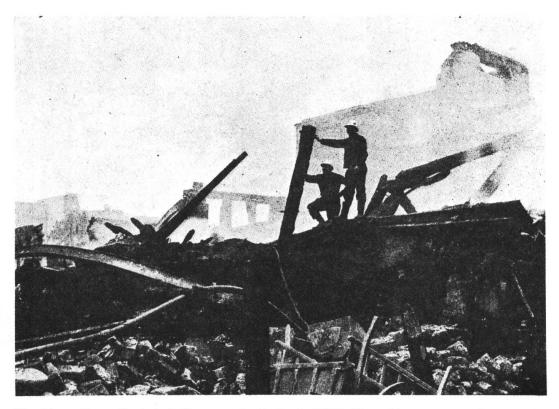
Fig. 11. — Incendie de la halle aux cuirs de Paris, 1906. Hennebique verse ce document au dossier de la combustibilité des structures métalliques.
