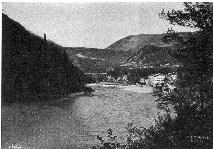
Eisenbahnbrücke bei Görz (Linie Görz-Köln), im Hintergrund der Karst.
