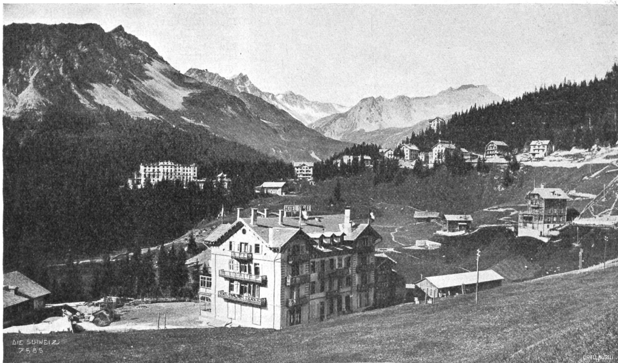
Das am 20. Februar abgebrannte Hotel Seehof in Arosa. Phot. W. Staub, Thalwil.
