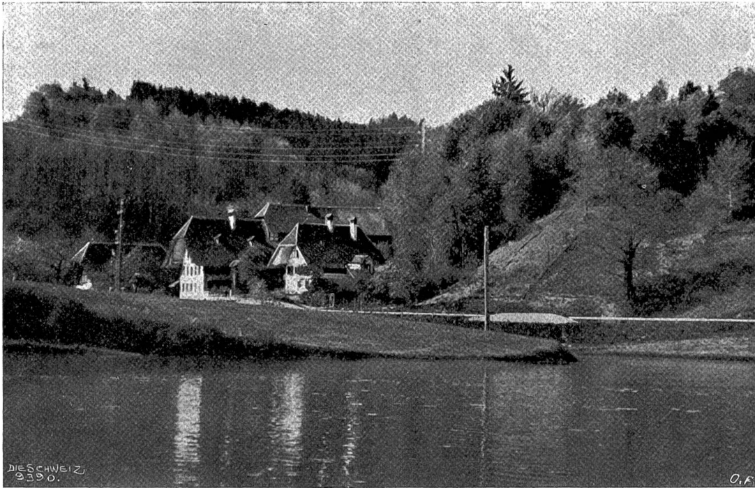
Der neue Wohlensee bei Bern (Hofenmühle). Phot. S. A. Schnegg.
