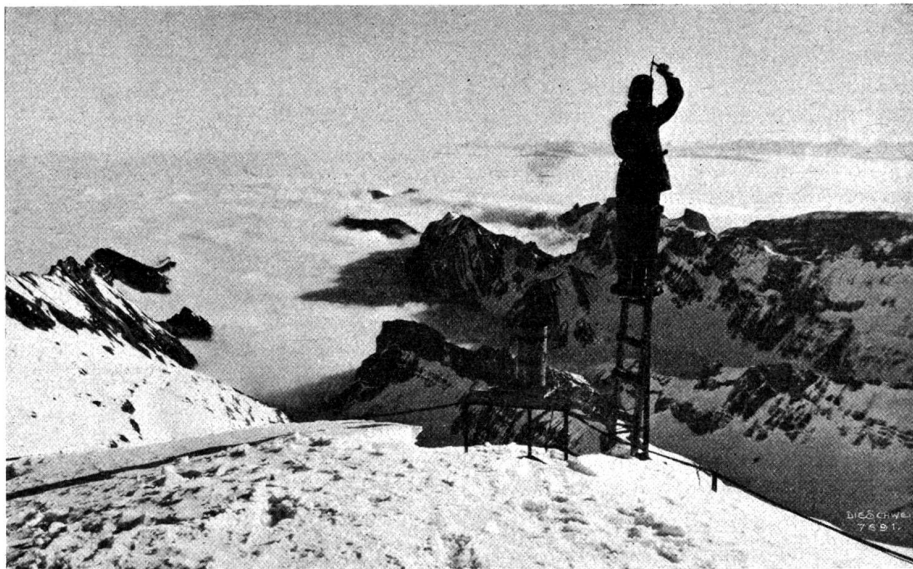
Von der Wetterwarte auf dem Säntis: Bei der Blitzableiter-Reparatur. Phot. G. Hablützel, Zürich.
